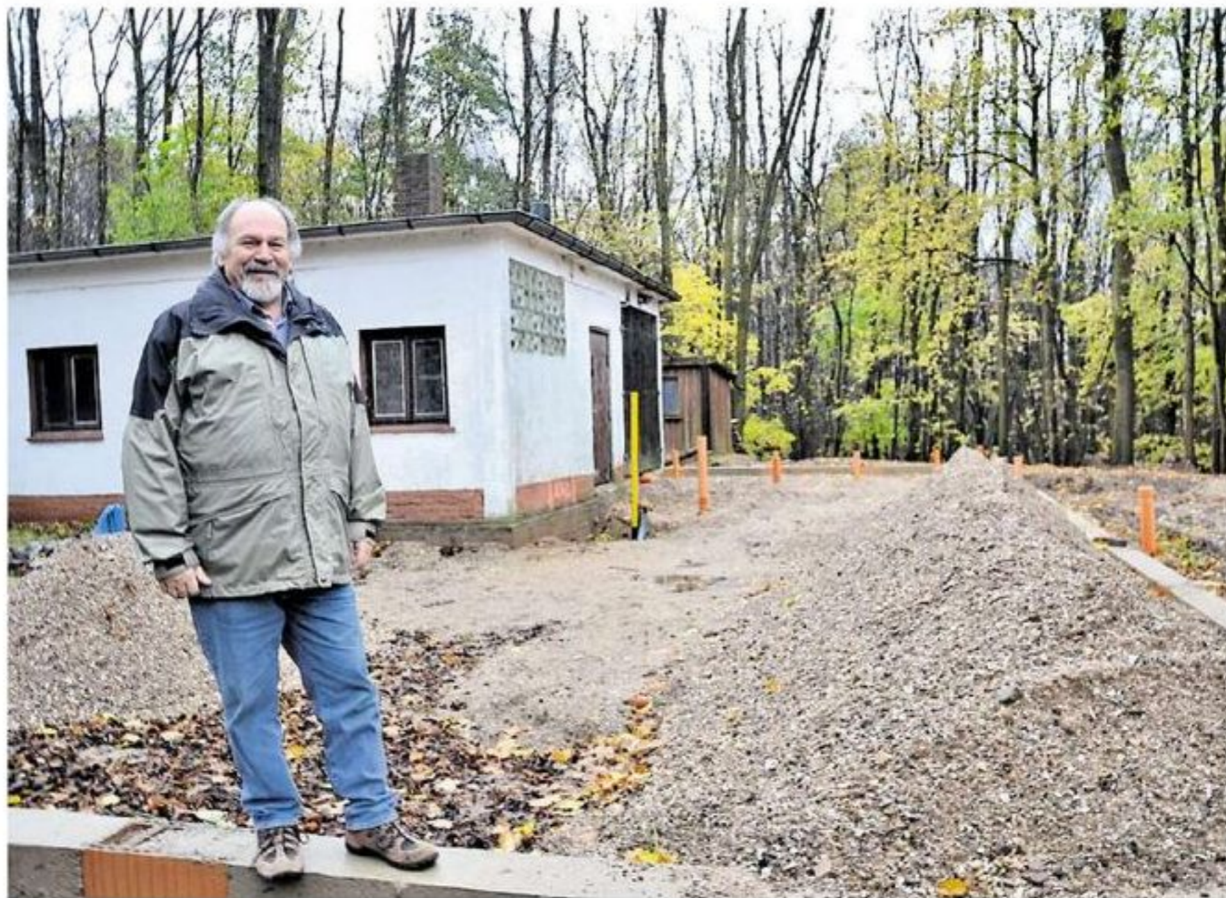
Hier im Wald entsteht das neue Domizil der Diekholzener Pfadfinder: das Schwedenhaus. Franz-Heinrich Horwath und auch einige Mitstreiter sind an Wochenenden auf der Baustelle am Werk. Fotos: Rath
