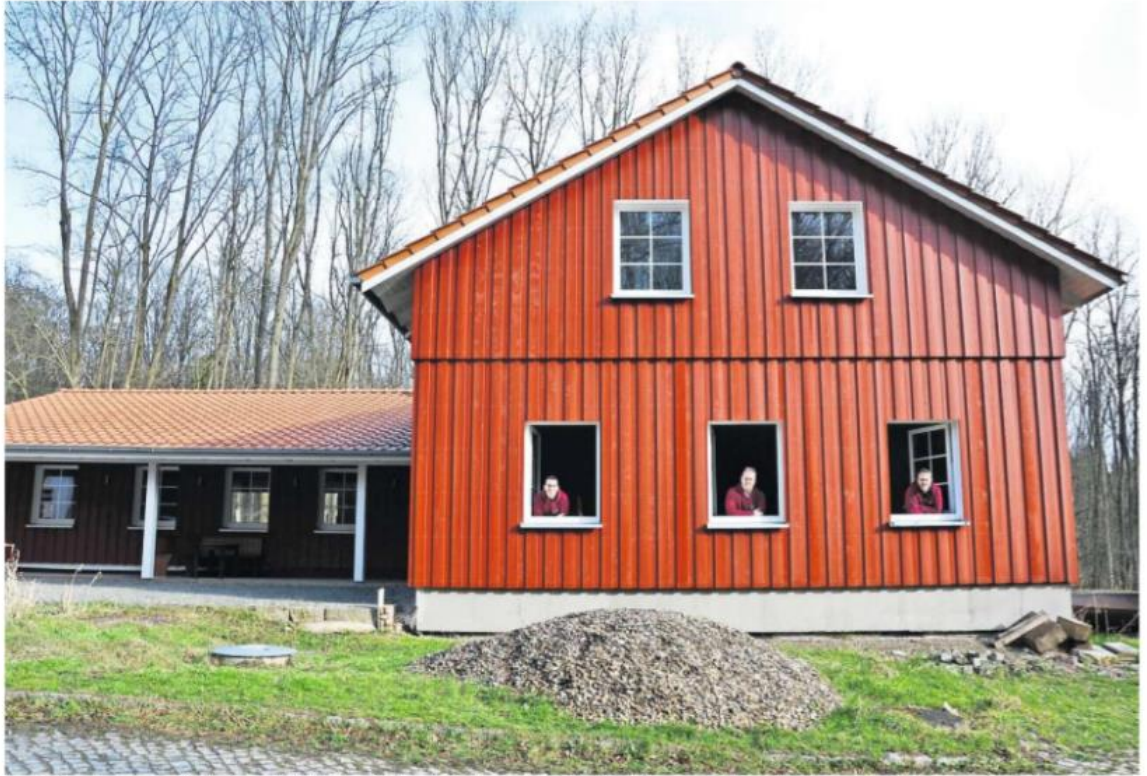
Fast fertig, aber eben nur fast: Alexander Höveling, Christoph Glados und Ralph Hartwich Stamm und dessen Förderverein hoffen, dass sie im Endspurt des Großprojektes in Diekholzen bald mit den Pfadfindern wieder richtig durchstarten können.
